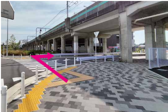
3 交差点を渡り右折。 ※歩道者用の信号がないので車に注意してください。
