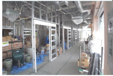
【1階 診察室引き戸取付】
