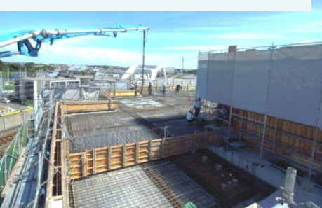
【III工区 3階立上りR階スラブ梁コンクリート打設】
