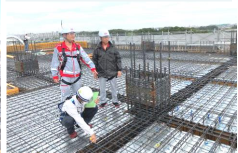
【5階梁床 II工区配筋検査】
