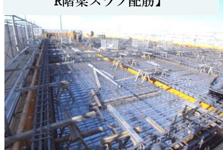
【I工区 5階立上りR階梁スラブ配筋】
