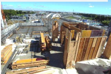
【I工区 5階立上り型枠鉄筋】
