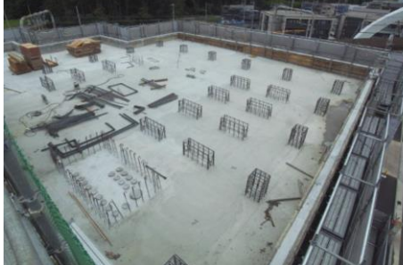
【III工区 R階 機械基礎配筋】
