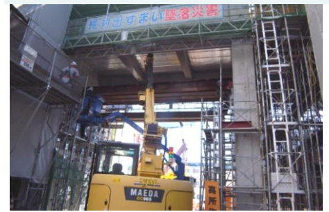
【病院棟～プラザ棟渡り廊下鉄骨架設支保工解体】
